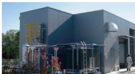
東京工場水処理設備
